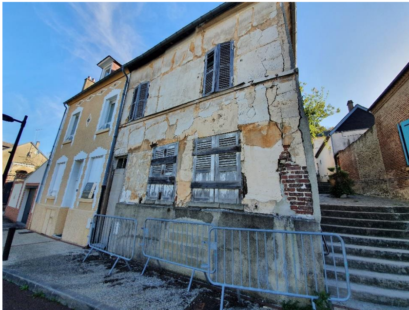
Vue générale de l'immeuble
