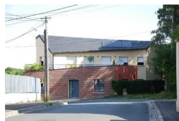
Petit immeuble collectif boulevard Bellevue
