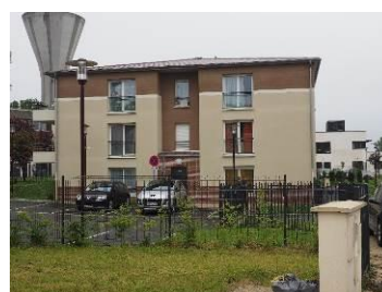
Immeuble collectif (R + 2)
