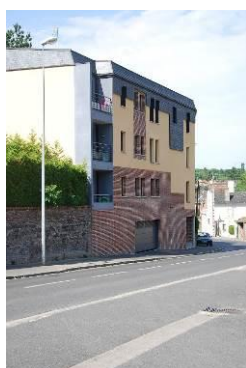
Immeuble à l'alignement rue Salengro
