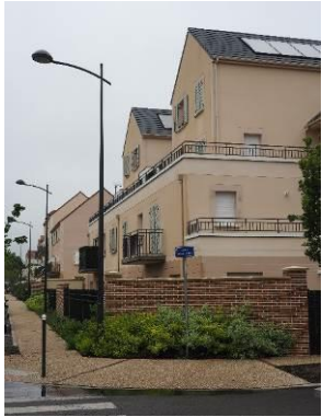
Immeubles terrasses (R + 3)
