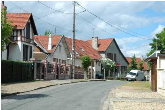
Bâti ancien en retrait
